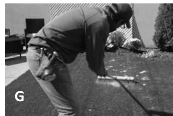
1. Dégager l'espace d'installation de tout objet, incluant le mobilier extérieur. S'assurer que la surface est propre et lisse. Pour éliminer les imperfections de la surface d'installation qui risqueraient de paraître à la surface du gazon synthétique, il est possible d'employer un autonivelant.
